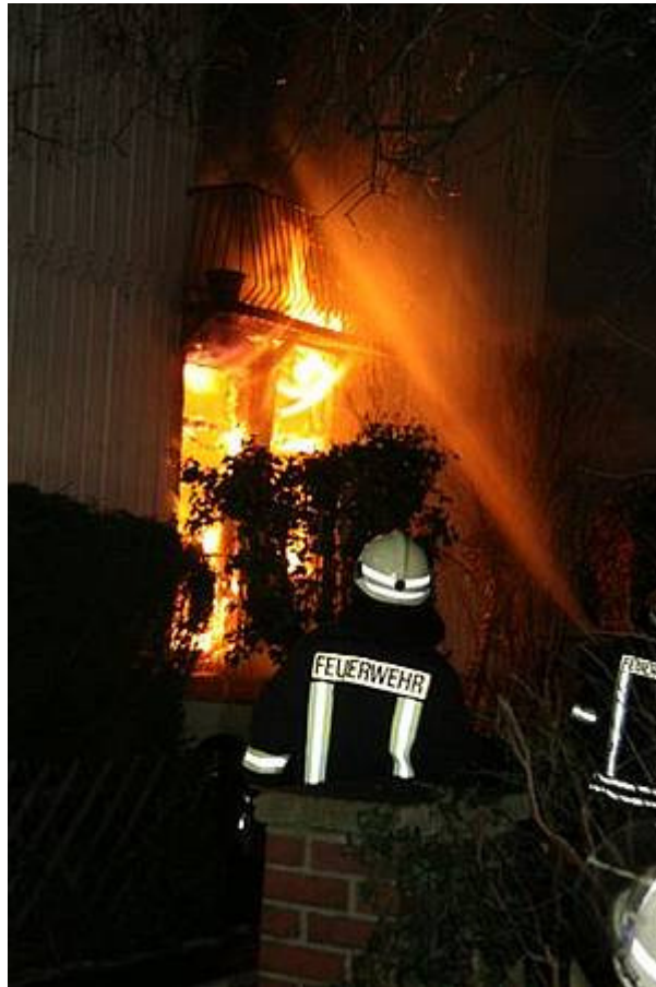
B-Rohreinsatz an der Südseite. Foto: Holger Schlegel GZ
