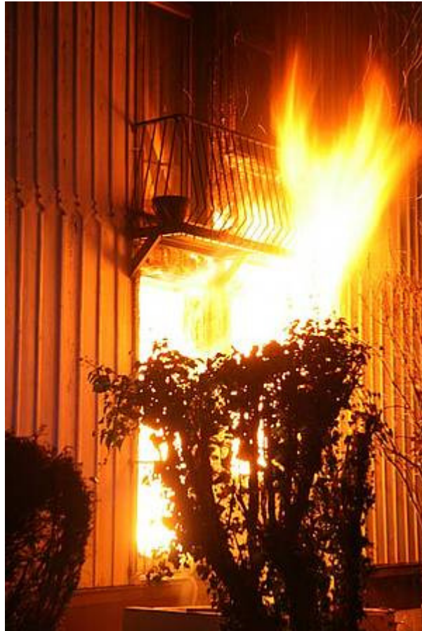
Situation an der Südseite kurz nach dem Eintreffen der Feuerwehr. Foto: Holger Schlegel, GZ
