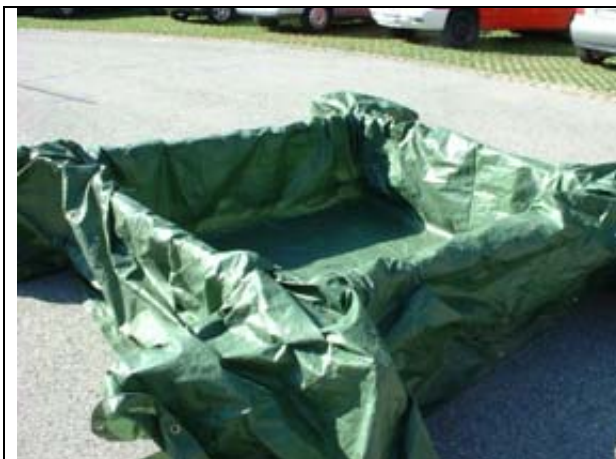
Die Plane wird in das Becken gelegt
